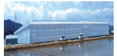
実証研究施設全体の外観
